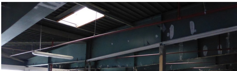
Figure 3. Détail de la toiture de HALLS SERVICE (03/2017)
